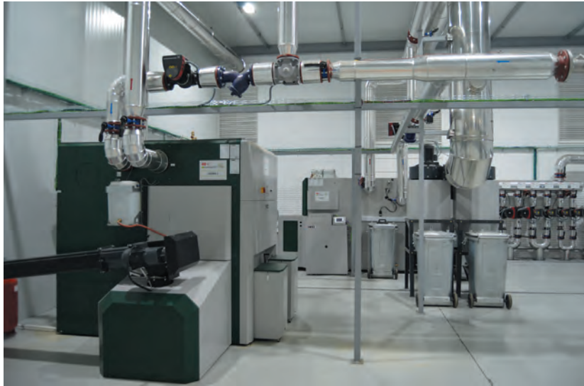
Sala de calderas de una red de calor (Foto: AVEBIOM)
