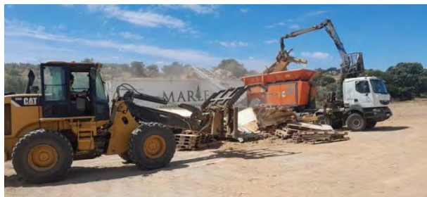
Pretriturado insitu en planta fotovoltaica
