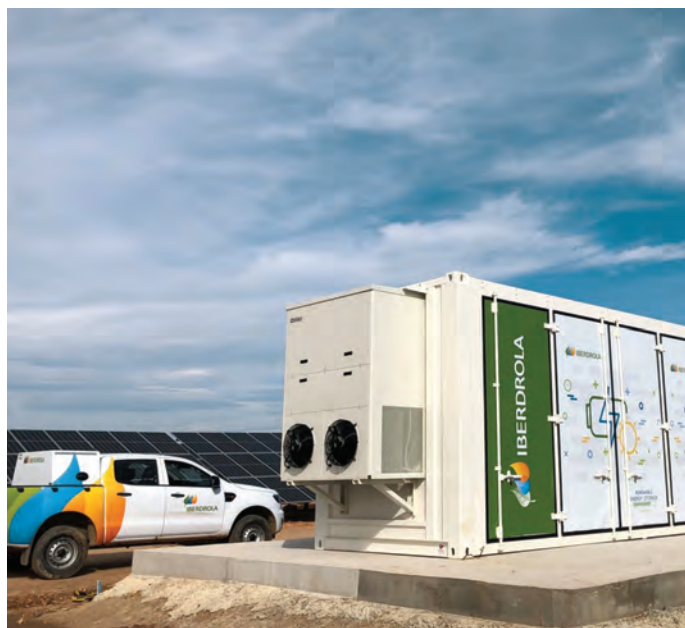
Sistema almacenamiento con batería en Campo Arañuelo
