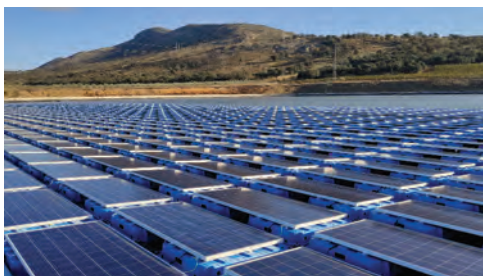
Instalación fotovoltaica flotante en la Comunidad de Regantes de Mérida
