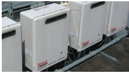
Calentadores alta eficacia colados en cascada, con suministro de gas natural y proceso de funcionamiento
