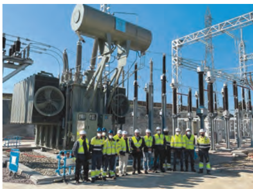
Puesta en servicio Trafo 220 kV 100 MVA
